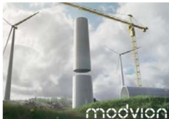
Inovativni drveni moduli Modvion-ovih drvenih turbinskih tornjeva presvučeni su poliurejom zbog različitih prednosti: poboljšava mehaničku zaštitu i, iznad svega, omogućuje ovoj zgradi vodonepropusnost i otpornost na vremenske utjecaje.
