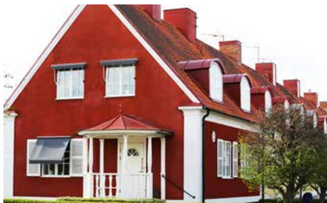
Fasad: Rost Fönster: Svan Knutar och fönsterfoder: Svan
