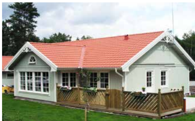
Fasad: Krusbär Fönster: Svan Knutar och fönsterfoder: Svan
