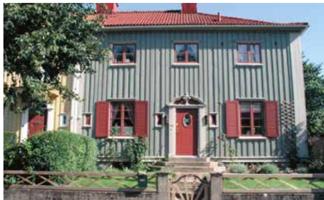
Fasad: Mosse Fönster: Svan Knutar och fönsterfoder: Rost
