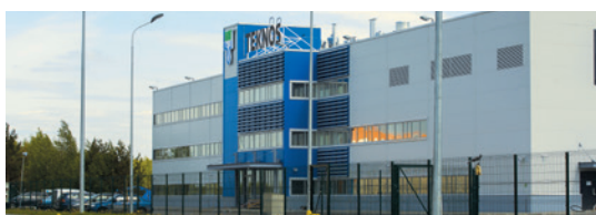
Завод в г. Санкт-Петербург, Россия
