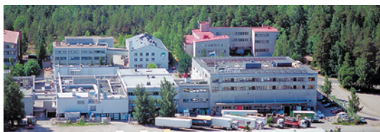
Центральный офис компании ТЕKNОС. Завод в г. Хельсинки, Финляндия
