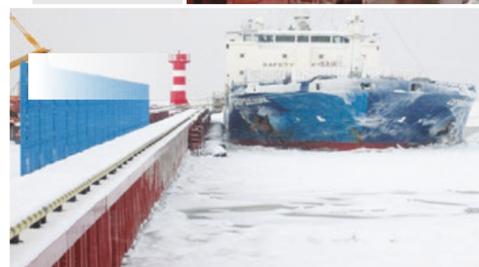
Шпунтовые ограждения порта Сабетта, INERTA 160
