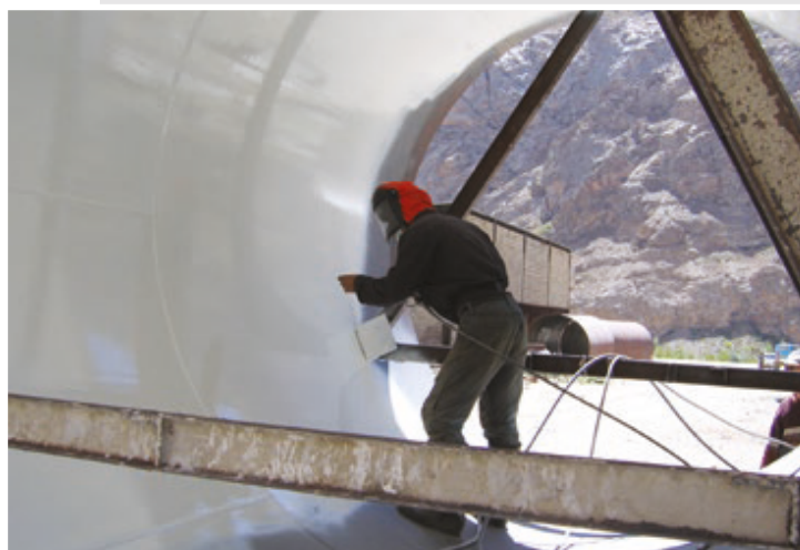
Водоводы Рогунской ГЭС INERTA 165 Tix
