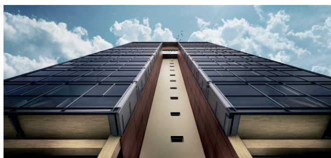
“TREET” I BERGEN, NORGE, VERDENS HØYESTE TREHUS – 52 METER HØYT OG 14 ETASJER. TEKNOS HAR LEVERT TEKNOS FR FACADE OG TEKNOS FR PANEL.
