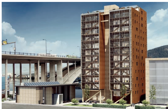
"Tree" i Bergen, Norge, verdens høyeste trehus – 52 meter høyt og 14 etasjer. Teknos har levert TEKNOS FR Facade og TEKNOS FR Panel.
