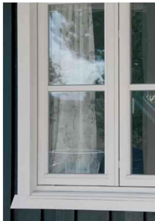
Conseil d'application: Les points faibles tels que les joints en V et les bois de bout devraient toujours être revêtus par aspersion ou par immersion.
