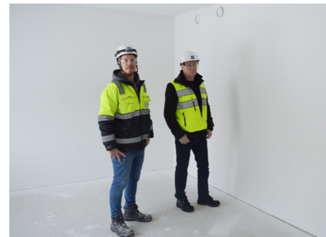
SL RAPPAUKSEN TYÖNJOHTAJA JARKKO KOSKINEN (VAS.) JA TVT ASUNTOJEN RAKENNUTTAMISVALVOJA PEKKA ANTTILA KATSASTAMASSA EKORA-PINTAA.
