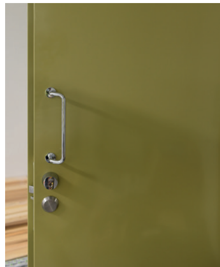
METALLITYÖ VÄLIMÄEN VALMISTAMAT, PIRTEÄN VÄRISET TERÄSOVET ON MAALATTU INFRALIT PE 8350-15 JAUHEMAALILLA.
