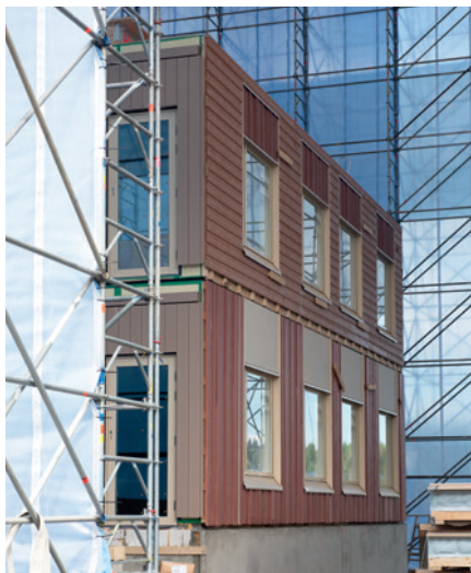
PUUELEMENTIT KOOTAAN SÄÄLTÄ SUOJATUISSA TELTOISSA.
