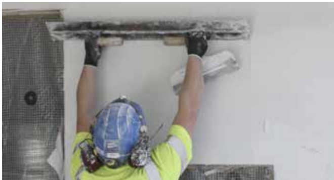
OLLI LEIJALAN MUKAAN TEKNOSPRO XS TASOITE TOIMII ERINOMAISESTI. TASOITETTA VOIDAAN KIERRÄTTÄÄ PUMPUSSA.
