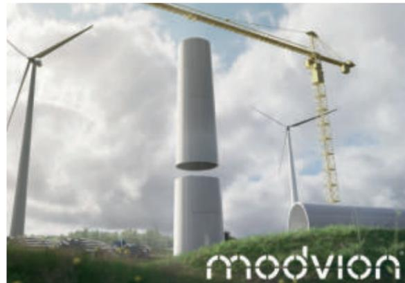
Die Schichtholzmodule von Modvion für Windturbinentürme aus Holz werden mit Polyurea beschichtet. Dies bietet verschiedene Vorteile: der Schutz vor mechanischer Belastung wird verbessert, außerdem ermöglicht Polyurea die Abdichtung des Turms sowie eine hohe Wetterbeständigkeit. Dies sind entscheidende Eigenschaften für diese Objekte.
