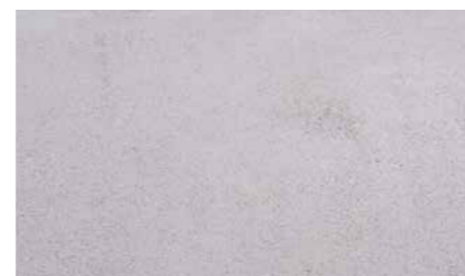
KÄSITTELEMÄTTÖMÄN BETONILATTIAN MAALAAMINEN:
