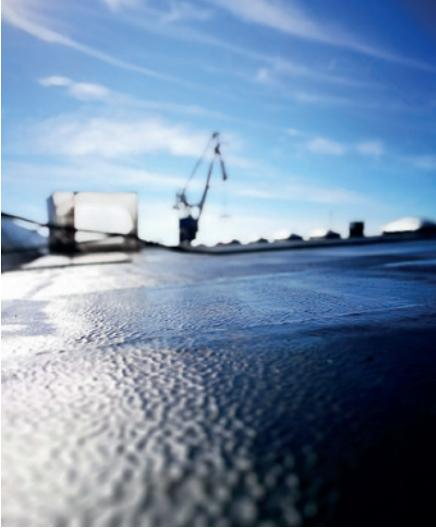
Polyurealla pinnoitettu ajoramppi kestää kovaa kulutusta.
