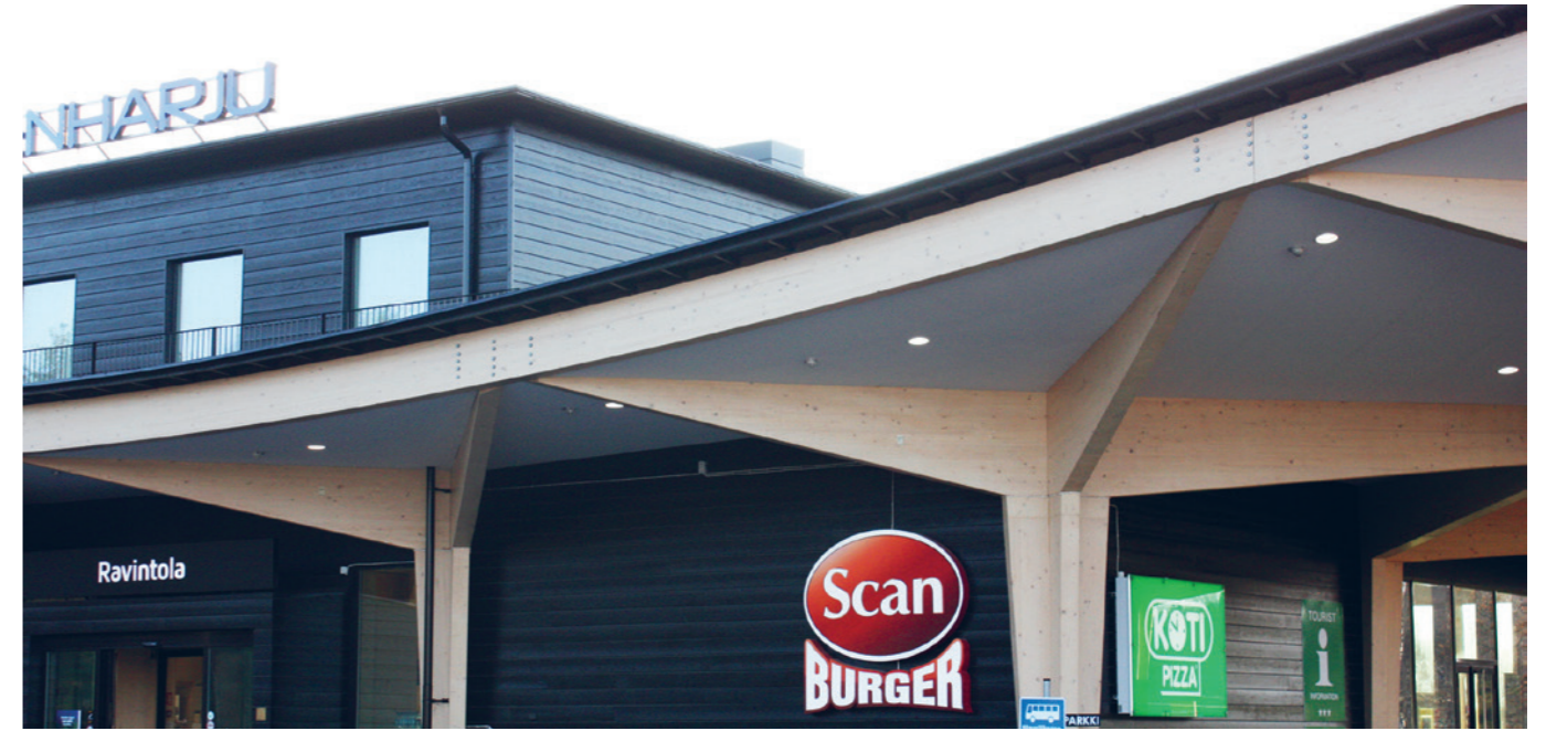
ULKOVERHAUS ON KÄSITELTY TEKNOSAFE -PALOSUOJAMAALAUSSJÄRJESTELMÄN MUKAISESTI. LIIMAPUUPALKKEJA SUOJAA PUOLESTAAN AQUATOP 2600-24 LAKKA.
