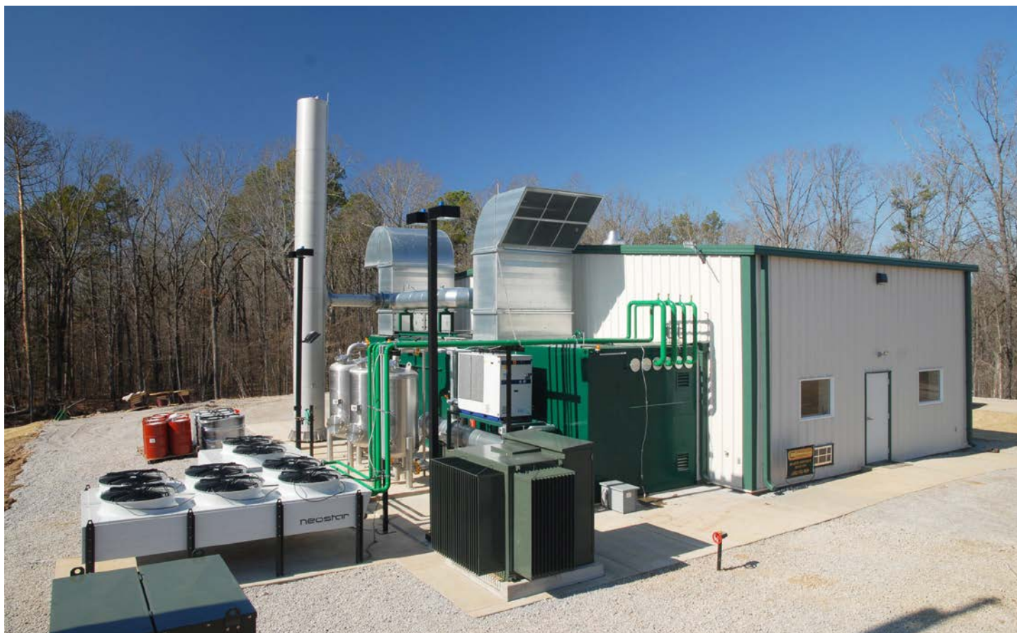
Lydteette specialcontainere til kraftvarmeværker er malet af Wenker.
