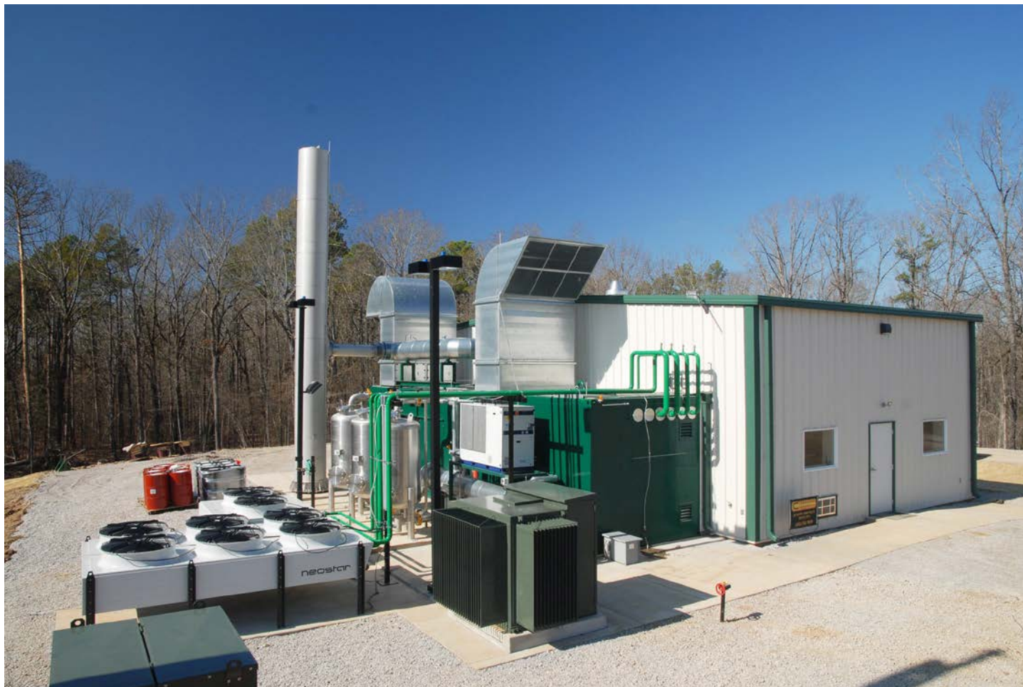
Voimalaitoksia varten suunnitellut äänieristetyt erikoiskontit on maalannut Wenker.
